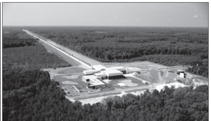
Obr. 1. Letecký pohled na čtyřkilometrové americké interferometry Advanced LIGO v Hanfordu (vlevo) a v Livingstonu (vpravo). Kvůli eliminaci lokálního šumu jsou od sebe vzdáleny 3000 km a pracují v koincidenčním režimu.
