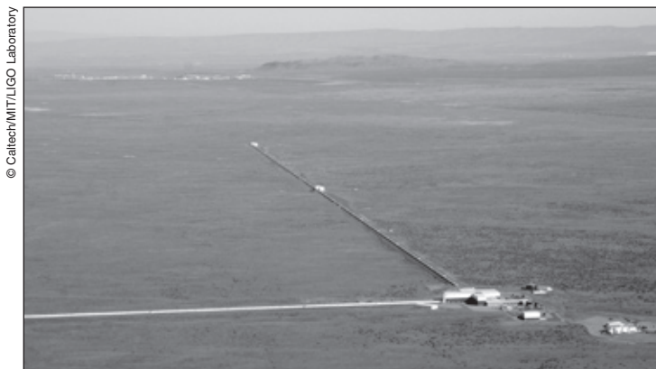
Obr. 1. Letecký pohled na čtyřkilometrové americké interferometry Advanced LIGO v Hanfordu (vlevo) a v Livingstonu (vpravo). Kvůli eliminaci lokálního šumu jsou od sebe vzdáleny 3000 km a pracují v koincidenčním režimu.
