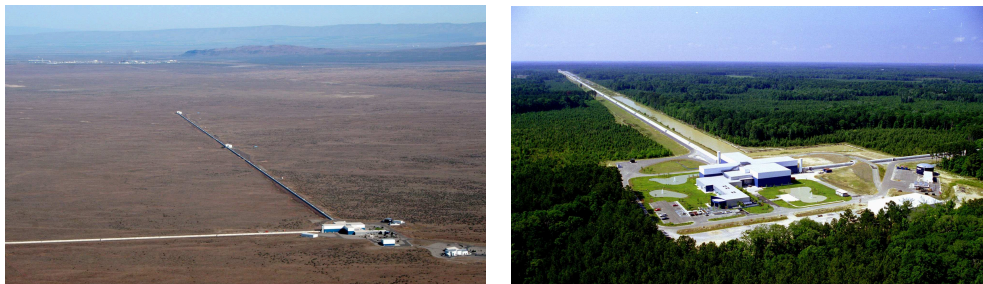
Obr. 2. Snímek čtyřkilometrového interferometru LIGO v Hanfordu (vlevo) a v Livingstonu (vpravo), USA. Jsou od sebe vzdáleny 3 000 km a pracují v koincidenčním režimu. Zdroj: Caltech/MIT/LIGO Laboratory.
