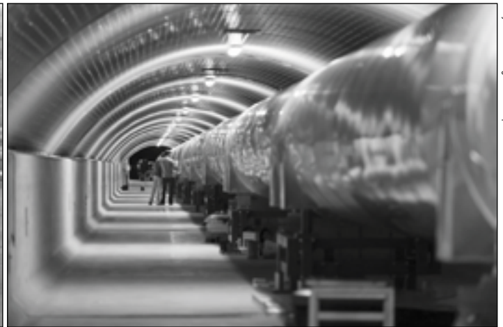
Pohled do 3km severního tunelu Virgo, ve kterém je umístěna vakuová trubice pro laserový svazek interferometru
