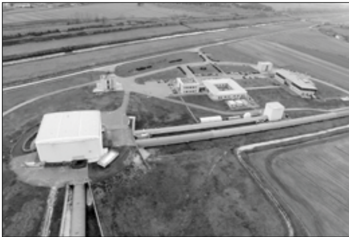
Hlavní budova detektoru Virgo a dvě 3km ramena z ní vyběhající. Patrný je rovněž 144m dlouhý čistící vstupní tunel a vzadu umístěné administrativní budovy.
